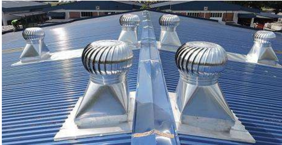
Gambar 29. Sirkulasi Udara dengan Turbo Ventilator
